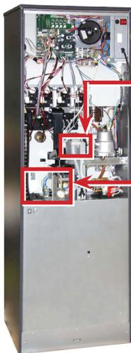
Снимите шланг с электроклапана, ведущий к расширительному бачку и подключите его к выходу помпы.
